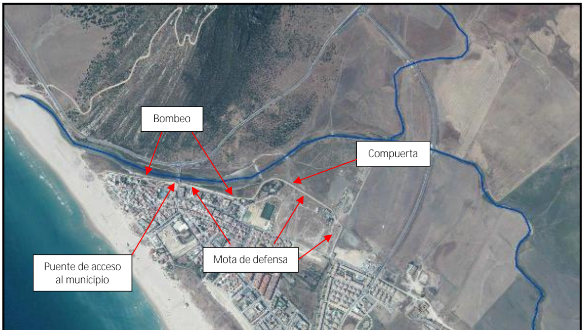
Tramo de cauce estudiado
